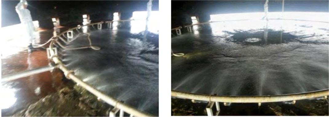
高速凝集沈殿池ジェット配管（修繕完了後）
