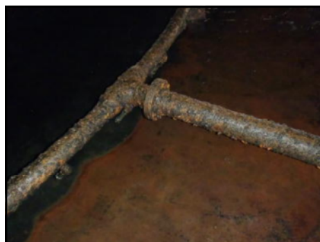
高速凝集沈殿池ジェット配管（修繕前）
