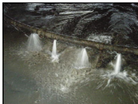
高速凝集沈殿池ジェット配管（修繕前）
