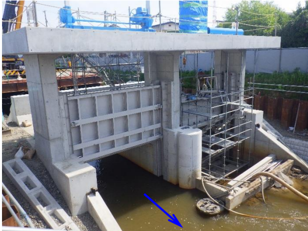
写真② 樋門本體工（下流側）
