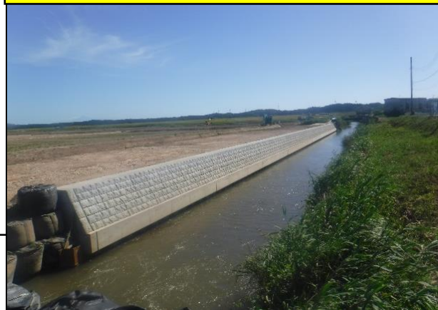
護岸ブロック
