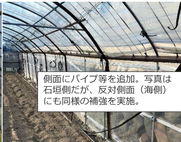
側面の補強（強風対策）
