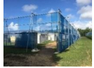
防風ネットの設置
