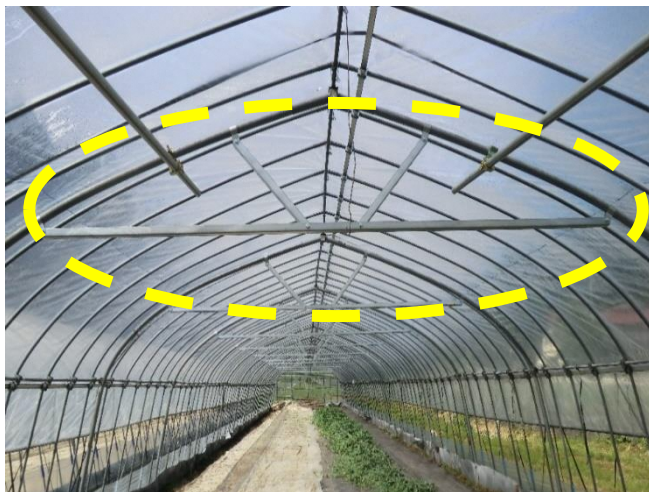
タイバーの設置による補強
