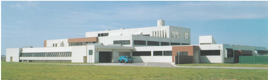
汚泥再生処理センター
