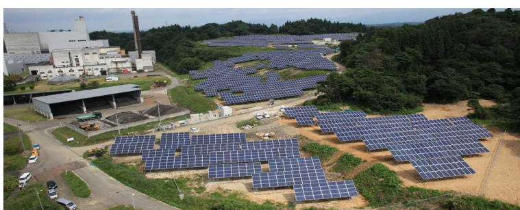
秋田市メガソーラー発電所
