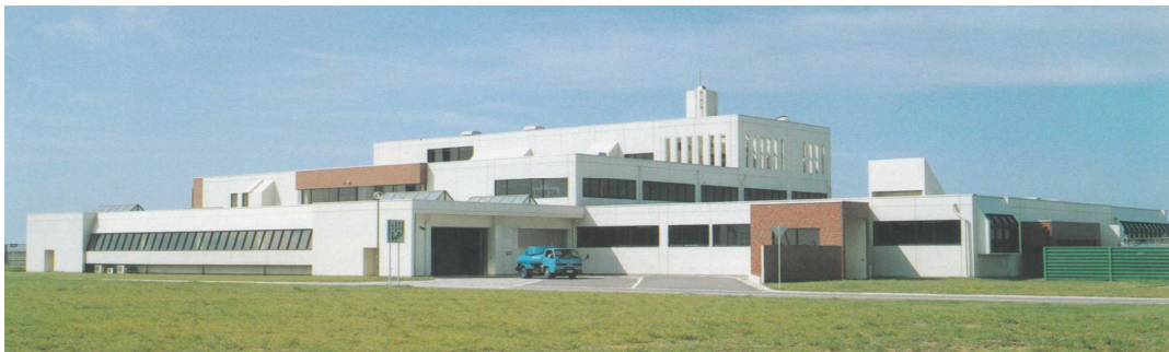
汚泥再生処理センター
