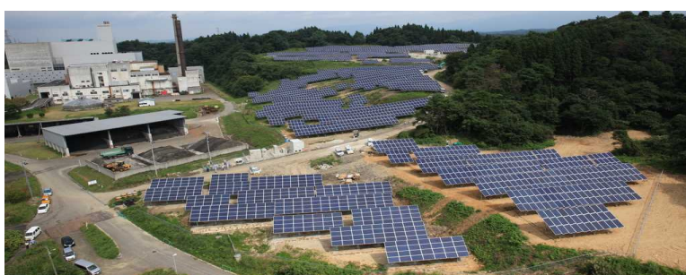
秋田市メガソーラー発電所
