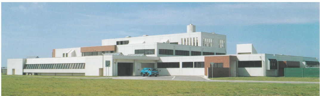
汚泥再生処理センター
