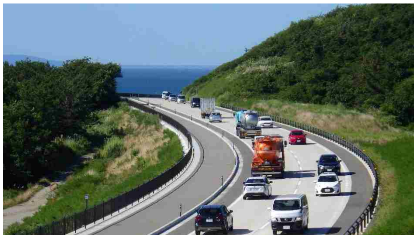
▲ 国道 7 号（下浜道路）の整備事例
