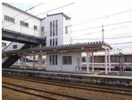
こ線橋の改築とともに、新たに設置された
