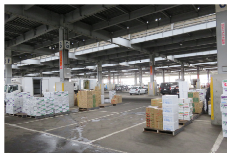
大屋根がかかった作業場 (札幌市中央卸売市場)
