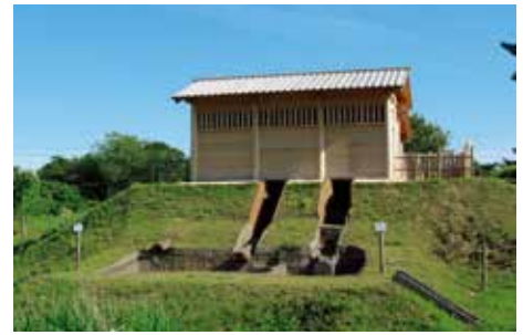
復元された水洗廁舎
