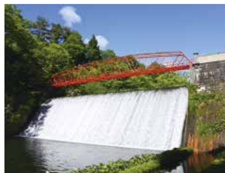
藤倉水源地水道施設
