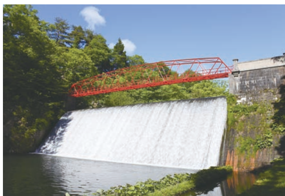
写真13 藤倉水源地水道施設
