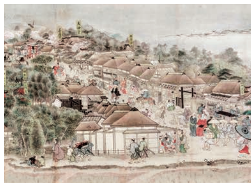
写真74 「秋田街道絵巻」(部分) 八橋の町並み
