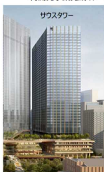
内幸町一丁目街区南地区第一種市街地 再開発事業完成イメージ
