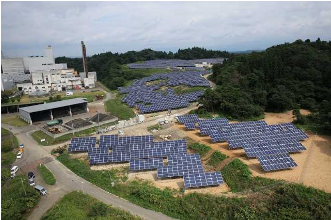
上空から撮影した秋田市メガソーラー発電所
