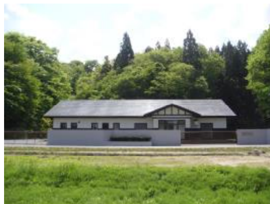
下北手中央農業集落排水処理施設
