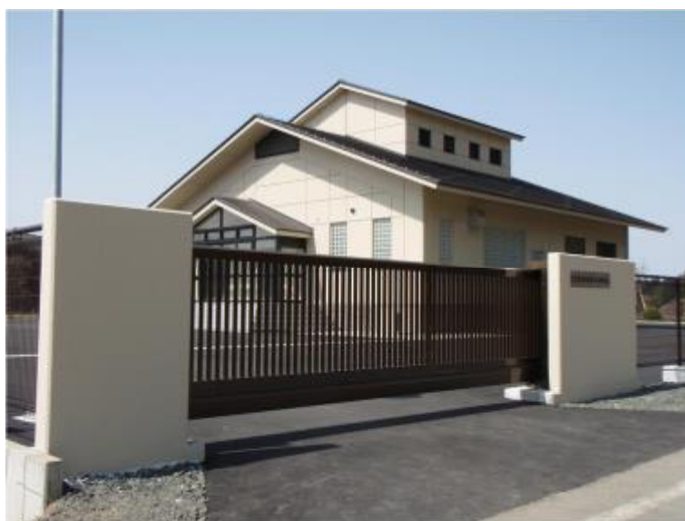
河辺岩見農業集落排水処理施設
