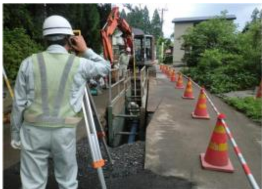
下水道管路工事
