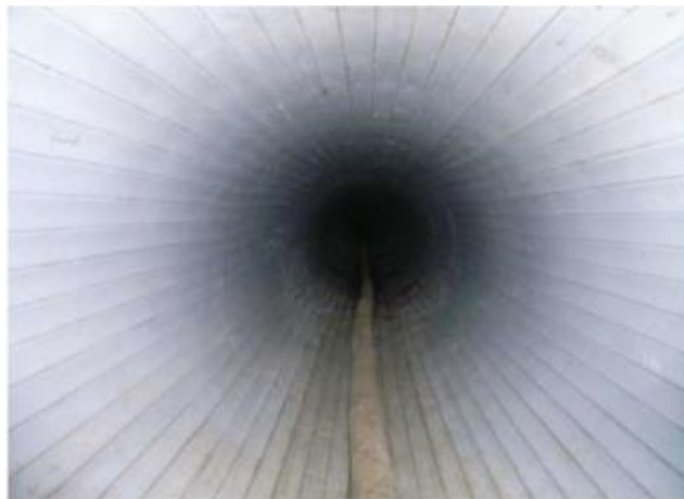
更生後の下水管の内面
