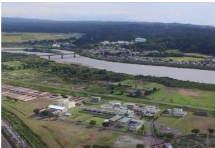
雄物川と仁井田浄水場（手前）、豊岩浄水場（奥）
