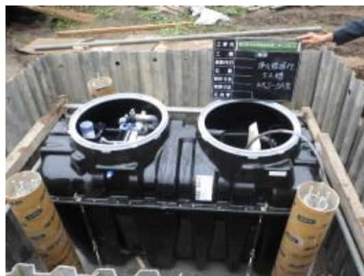
市設置浄化槽工事
