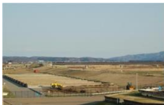
仁井田浄水場天日乾燥床
