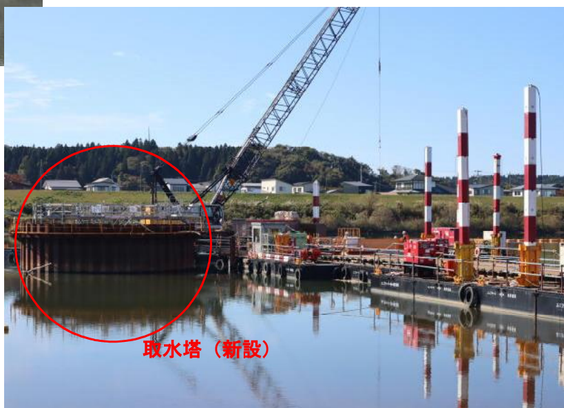
【R6.11 仁井田浄水場取水導水施設の新設工事】
