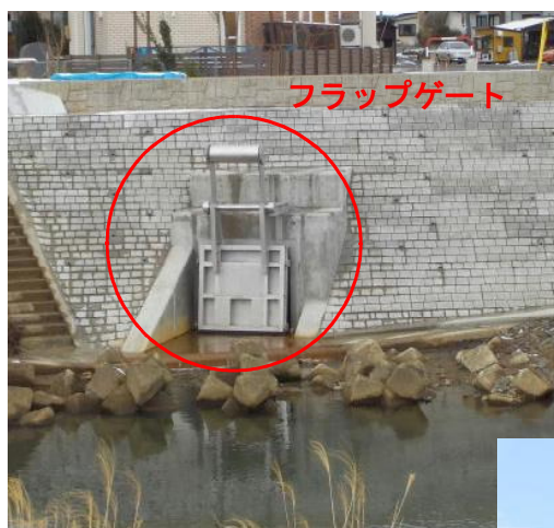
【フラップゲート施工例：太平川（広面字谷内佐渡）】
