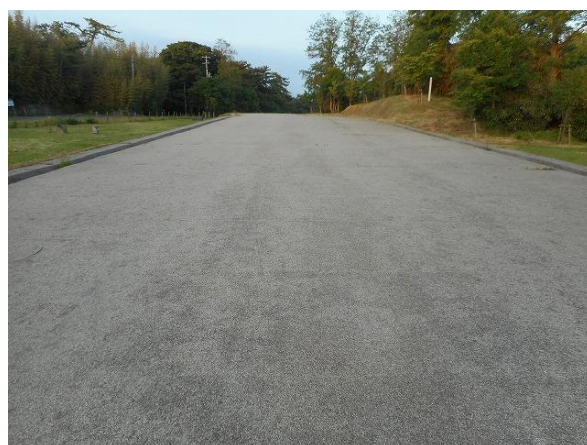
⑥城内東大路 透水性樹脂舗装
