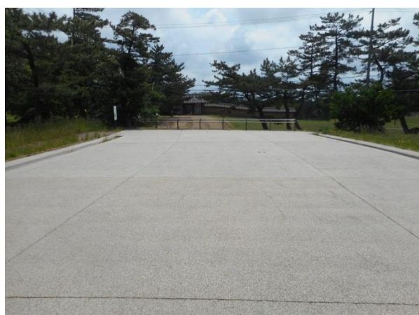
写真 8-11 城内東大路透水性樹脂舗装
