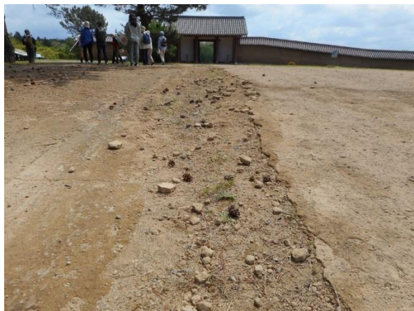
写真 8-7 城内東大路土系舗装
