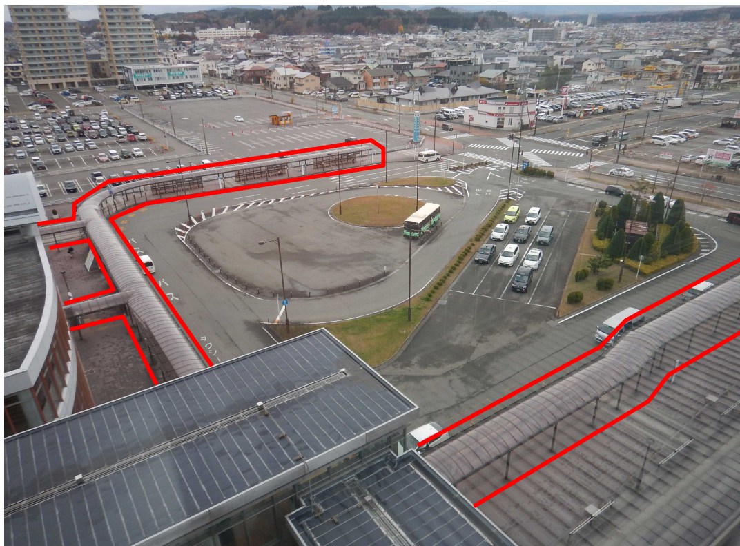
シェルター設備 全景
