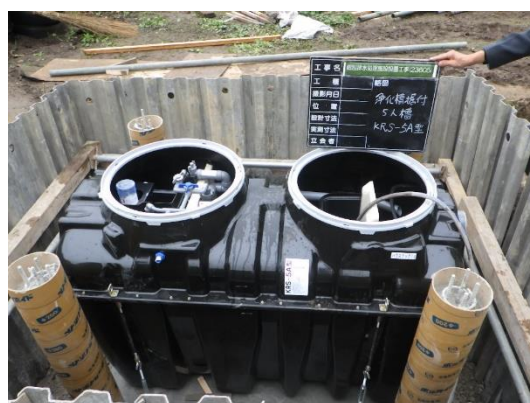
市設置浄化槽工事
