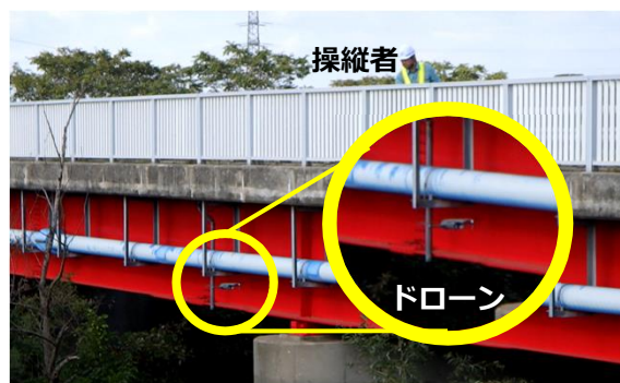
ドローンを活用した点検
