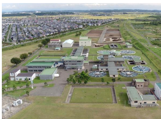
仁井田浄水場
