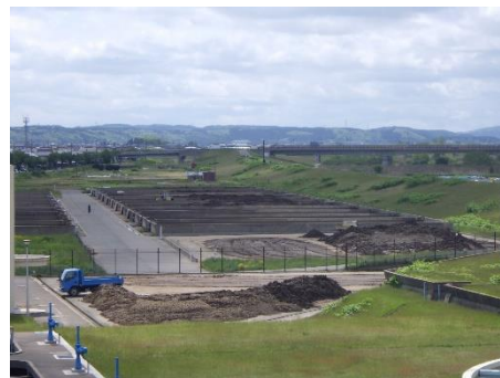
仁井田浄水場天日乾燥床
