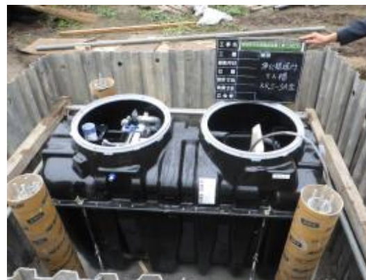
市設置浄化槽工事
