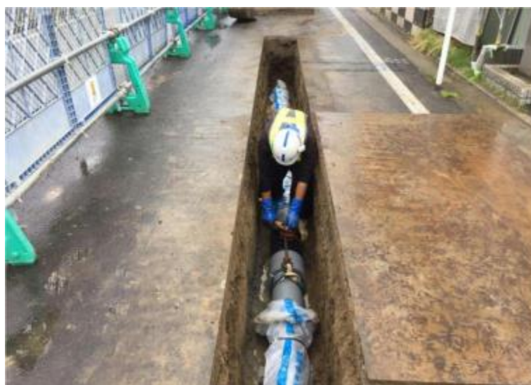
水道管の布設工事
