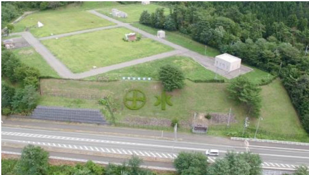
手形山配水場
