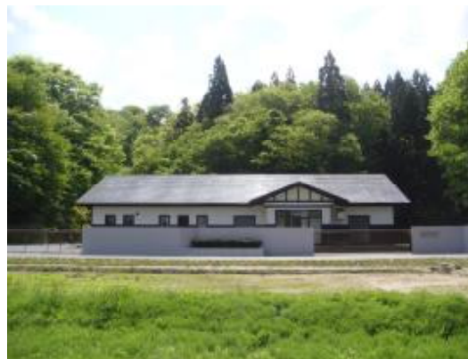
下北手中央農業集落排水処理施設
