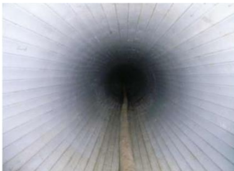
更生後の下水管の内面
