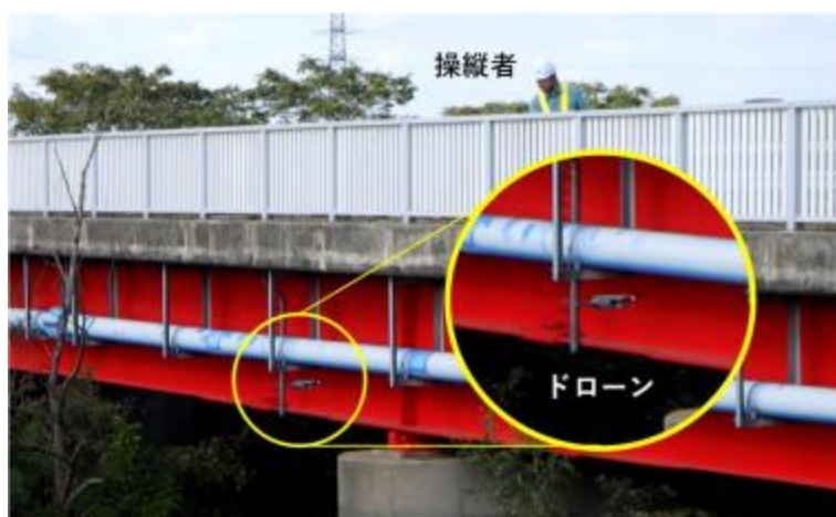
ドローンを活用した点検
