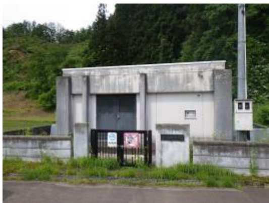
萱ヶ沢ポンプ場
