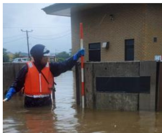
広面汚水中継ポンプ場
