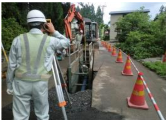
下水道管路工事
