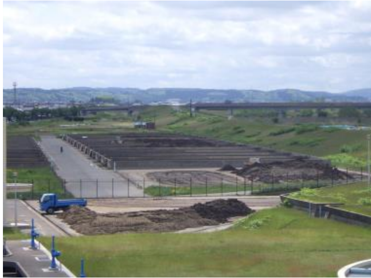
仁井田浄水場天日乾燥床
