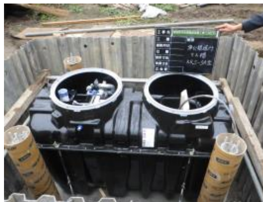
市設置浄化槽工事
