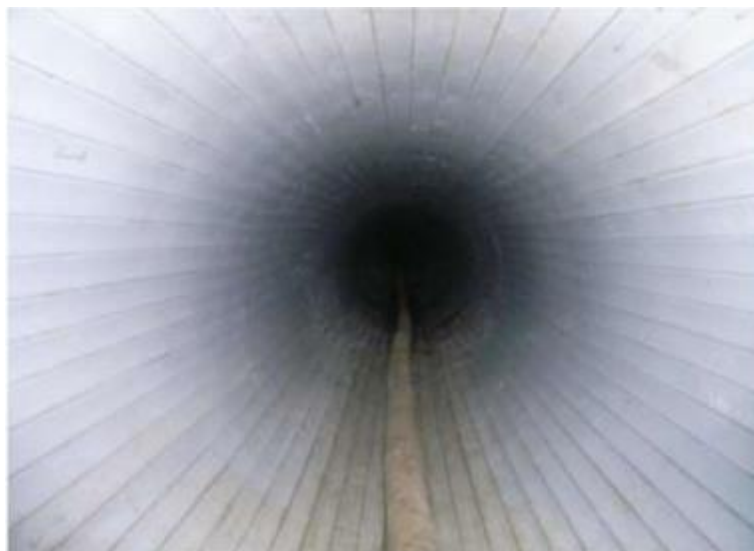
更生後の下水管の内面
