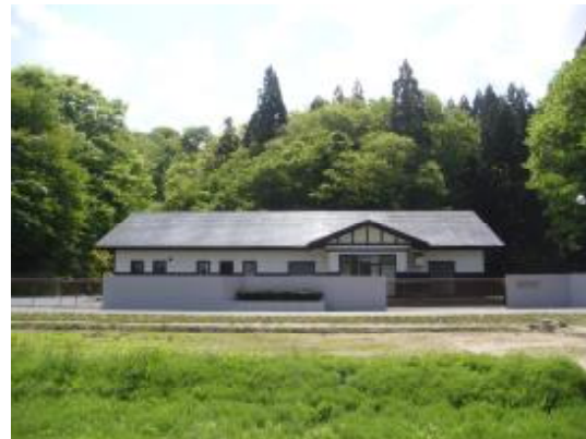
下北手中央農業集落排水処理施設
