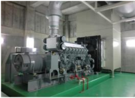
非常用発電設備（左：豊岩浄水場、右：八橋汚水中継ポンプ場）
