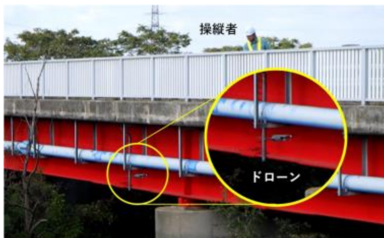
ドローンを活用した点検
