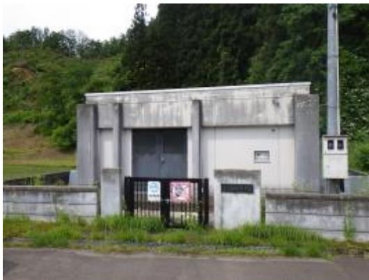
萱ヶ沢ポンプ場
