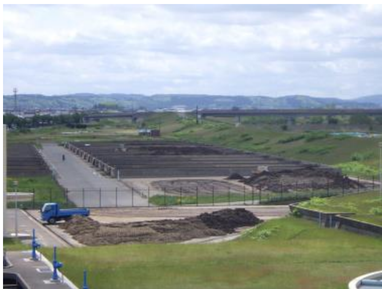
仁井田浄水場天日乾燥床
