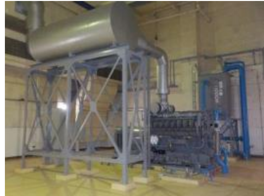
非常用発電設備（左：豊岩浄水場、右：八橋汚水中継ポンプ場）
