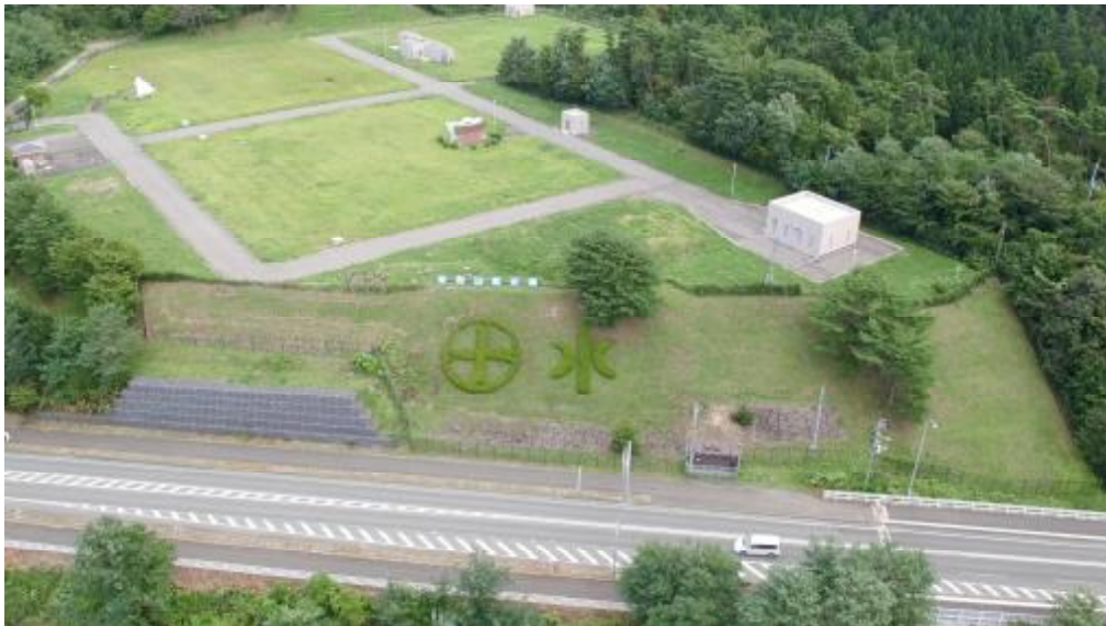
手形山配水場
