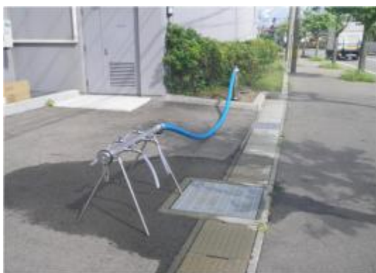
応急給水施設（応急給水栓）
