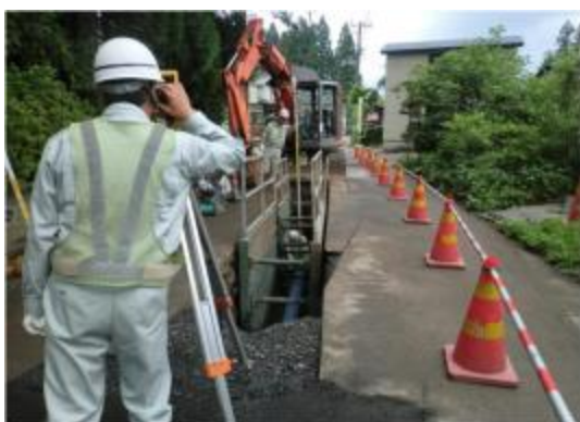
下水道管路工事
