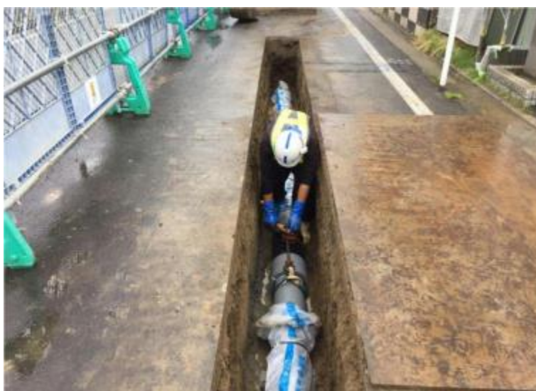
水道管の布設工事
