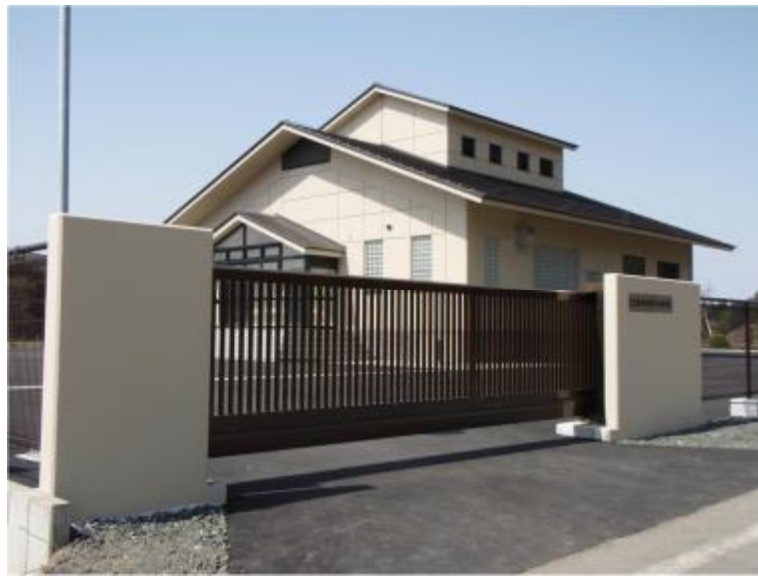
岩見農業集落排水処理施設
