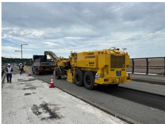
車道切削状況 (R7. 8)
